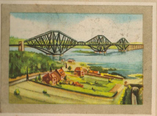
Pont sur le Firth of Forth (Angl.) - Le golfe de Forth en Ecosse est traversé par un immense pont métallique d'une long. de 2527 m. La portée des arches est de 520 m. Il est dû à Fowler et Baker qui l'achevèrent en 1889.
