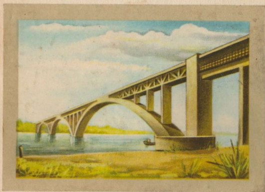
Pont de Plougastel (France) - Le pont de Plougastel sur l'Elorn en Bretagne fut construit en béton armé par Freyssinet. Il a 800 m de long et est constitué par trois arcs de 195 m d'ouverture.
