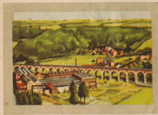
Pont de Dolhain (Belgique) - Le viaduc de Dolhain sur la Vesdre nommé "Pont des grands Prés" est un des plus remarquables de la Belgique. Il a 268 m de long et 20 m de haut. Il comprend 20 arches de 10 m.
