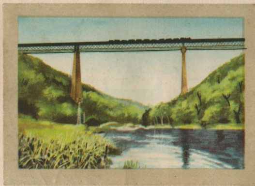
Viaduc "des Fades" en Auvergne (France) - Le viaduc des Fades en Auvergne s'élève à 132 m au-dessus du niveau de la Sioule. La hauteur des piles atteint 92 m, la portée entre les piles 144 m, la longueur 475 m.
