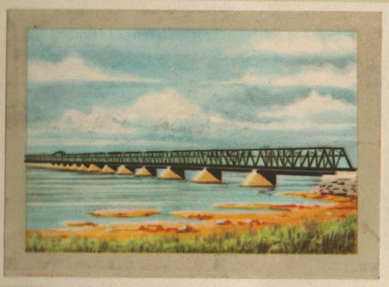
Pont Victoria Jubilee (Canada) - A Montréal fut jeté sur le Saint-Laurent un des ponts les plus longs du Canada: le pont Victoria Jubilee. Il repose sur 25 piles et mesure 2200 m de long.
