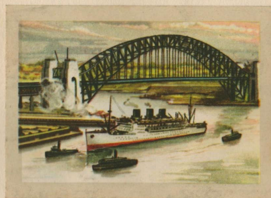
Pont de Sydney (Australie) - Le fameux pont du port de Sydney fut terminé en 1932. La portée atteint 1148 m sur une longueur totale de 1250 m. 2 trottoirs, 1 route et 4 voies ferrées s'alignent sur la largeur.
