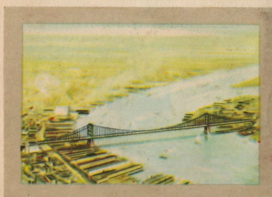
Pont Delaware (E.U.) - En 1926 un pont d'une long. de 1100 m fut jeté sur la Delaware entre Philadelphie et Camden. Six chaussées et deux trottoirs y furent aménagés. Il coûte plus de deux milliards de francs.
