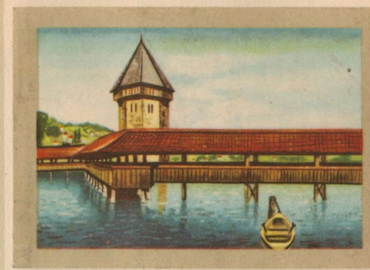
Pont en bois à Lucerne (Suisse) 170 m - La Reuss divise la ville de Lucerne (Suisse) en deux parties inégales, reliées par cinq ponts. Le pont couvert, en bois, appelé Pont de la Chapelle, est le plus ancien. (1333).
